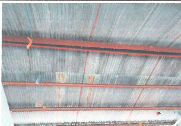
Foto 3: Área donde se desea el mejoramiento del techo en el nivel primario
