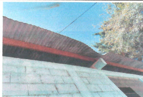
Foto 2: Área donde se desea el mejoramiento del techo en el nivel primario
